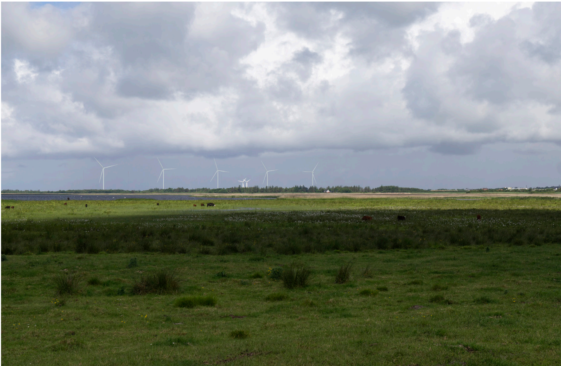
8: Ulf sundvej Visualisering af fremtidige forhold (fem ens vindmøller). Navnhøjde 165 (maks), rotordiameter 220, totalhøjde 275 (maks). Afstanden til nærmeste planlagte prototypevindmølle er ca. 3,9 km fra fotostandpunktet.
