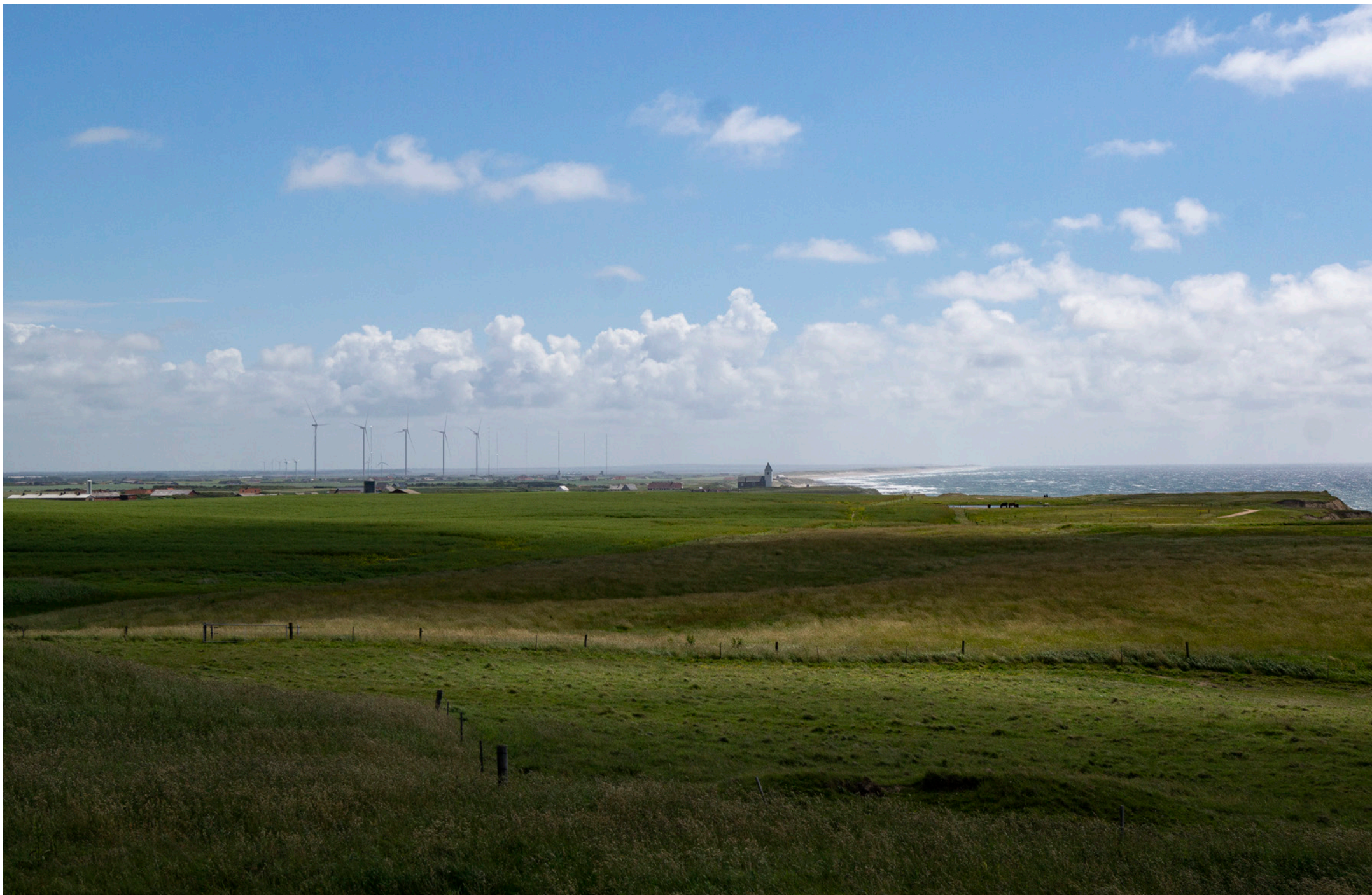
11: Bovbjerg Fyr Visualisering af fremtidige forhold (fem ens vindmøller). Navnhøjde 165 (maks), rotordiameter 220, totalhøjde 275 (maks). Set i samspil med de eksisterende vindmøller ved Fjaltring. Afstanden til nærmeste planlagte prototypevindmølle er ca. 6,9 km fra fotostandpunktet.
